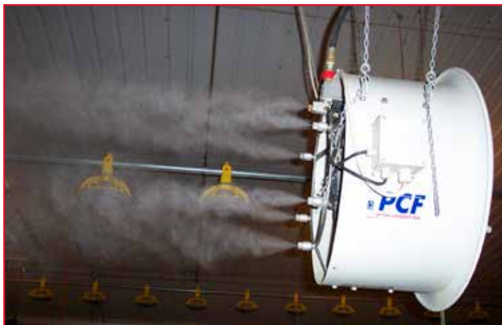
Figura 14: Uso de un aspersor para aumentar la HR durante la crianza.
