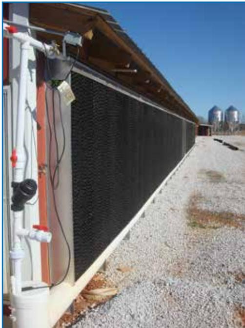
Para que el sistema de ventilación de túnel funcione de manera eficiente, es importante calcular correctamente el área de los paneles enfriadores con base en la capacidad total de operación de los ventiladores.
