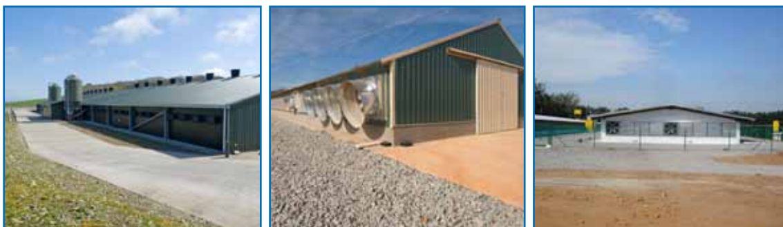
Figura 6: Naves con bajo riesgo de bioseguridad, con áreas de hormigón en sus perímetros, en vez de vegetación.
