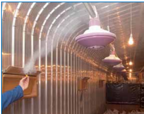
Figura 107: Placas direccionales adaptadas a una entrada de aire.
