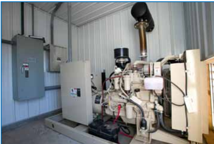
Figura 100: Ejemplo de un generador de respaldo.
