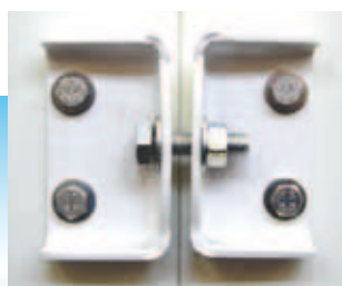
Pincettes d'assemblage des modules à rupture de ponts thermiques
