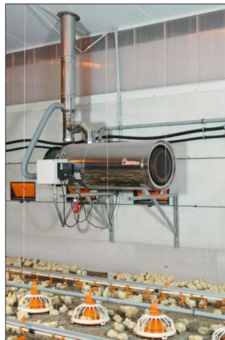
RGA 100 – calefactor de gas con chimenea
