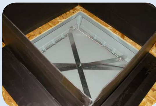
Vista superior de la entrada desde el ático en posición cerrada/trabada.
