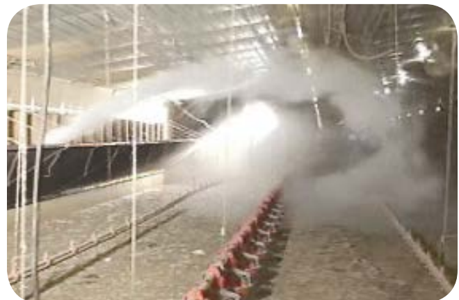
El aire se dirige hacia arriba y luego baja y se arremolina alrededor del centro del galpón para proporcionar una excepcional mezcla de aire
